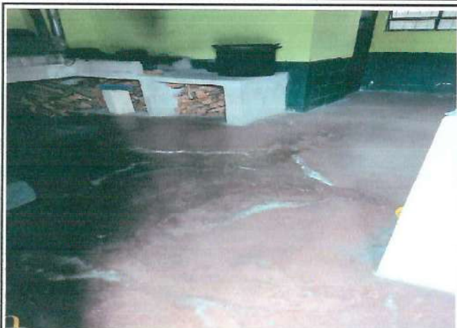
Foto 1: REPARACION Y MEJORAMIENTO DE ÁREA DE COCINA
