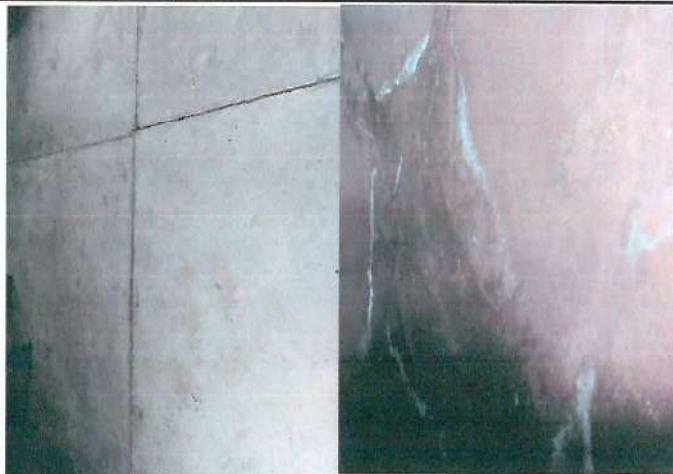
Foto 2: SUSTITUCIÓN DE PISO EN AULAS
